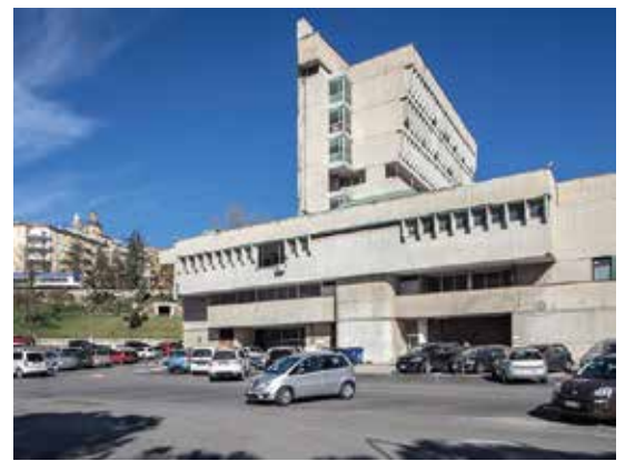
Macerata, via Pesaro, la nuova sede del tribunale vista dal parcheggio sottostante (foto LUCA GIRARDINI)
