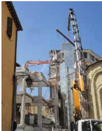
Giugno 2022: il palazzo di giustizia di piazza Mazzini, gravemente lesionato dal terremoto del 26 e 30 ottobre 2016, viene demolito
