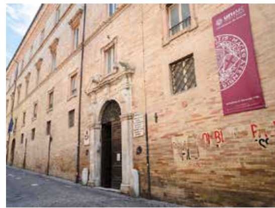
Macerata, via Garibaldi, la vecchia sede del tribunale, abbandonata nel 1973 (foto ANDREA PETINARI)
